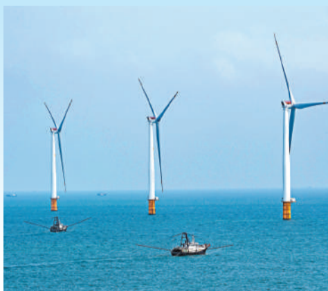
◆廣東目前規劃風力發電的重大建設項目總投資超1,500億元人民幣。受訪者供圖
