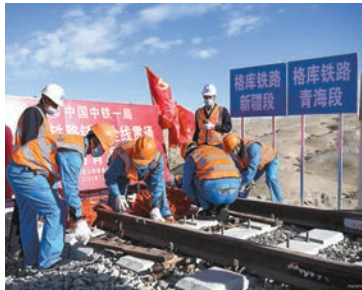
■格庫鐵路實現了全線鋪通。圖為中鐵一局的施工人員在格庫鐵路新疆段連接最後一組軌排。新華社
